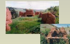
Examples of pisé house construction
